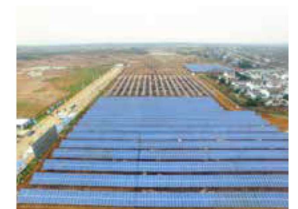
Nanjing Pukou - 14.2MW
